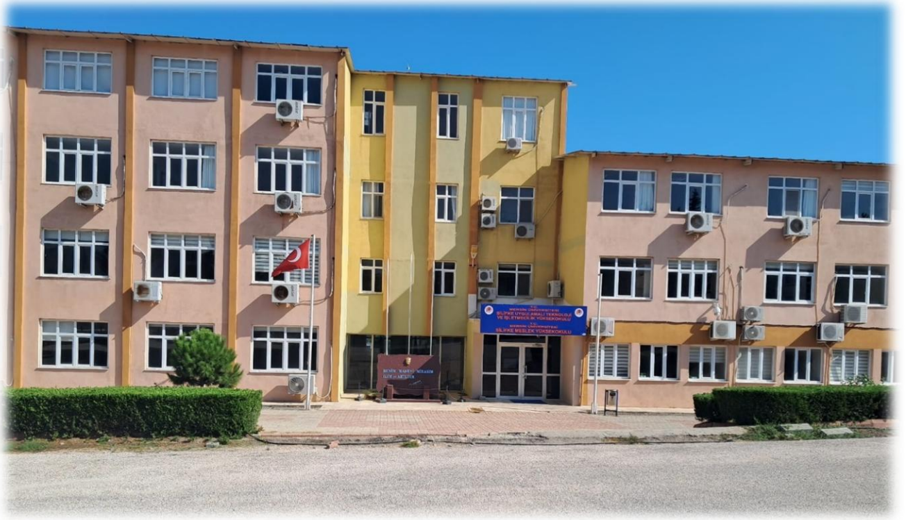
Tadilat ve Bakım İşlemleri - Yeni Hali (Yüksekokul Binası Ön Cephe)
