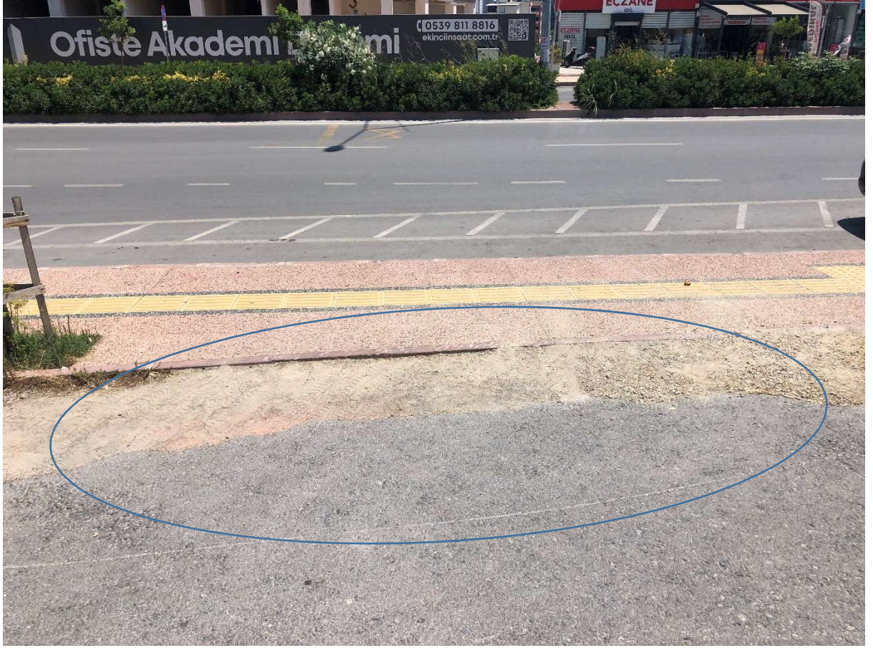
Beton dolgu yapılması gereken alan (yaklaşık 1-2 m3)
